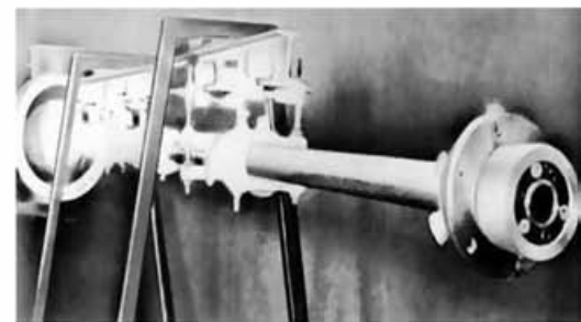
Նկ. 7. Էլեկտրամագնիսական պլազմայի թնդանոթի լուսանկարը
