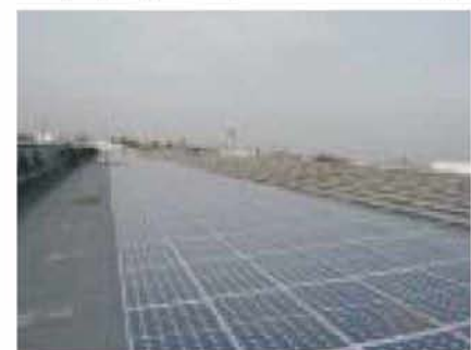
Նկ. 5. Շենքին ինտեգրված 5 մՎտ հզորությամբ ՖՏԷ կայան Գերմանիայում
