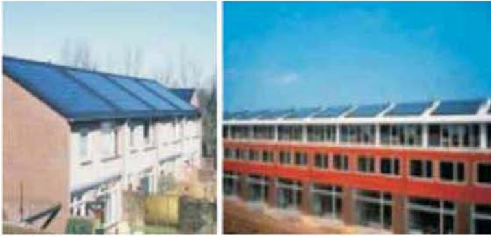
Նկ. 6. Ծեփին ինտեգրված յուրաքանչյուրը 1 մՎտ հզորությամբ ՖԷ կայաններ Նիդեռլանդներում
