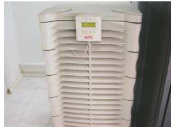
Նկ. 10. APS Symmetra 16kVA Power Array-ի արտաքին տեսքը
